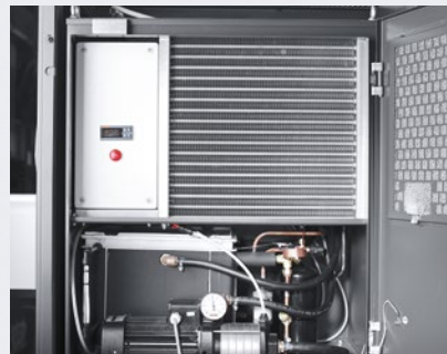
Kühlung: Invertergesteuerte Anlagen für eine bedarfsorientierte Kühlleistung*
